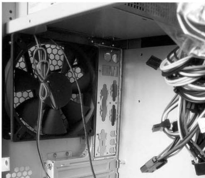
Рис. 15.3. Использование дополнительного вентилятора
